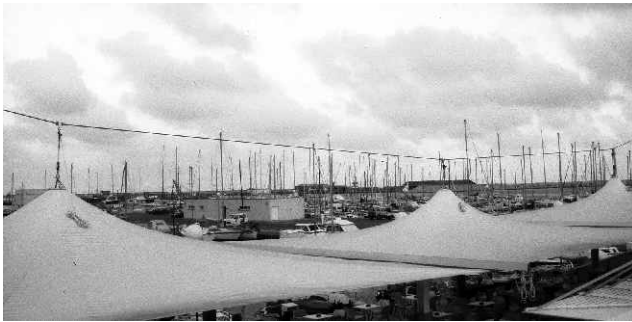
Vela tensoestática de 3 cuerpos para terraza. Puerto Vilanova i la Geltrú. Barcelona
