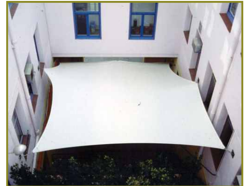
Sombra textil patio interior edificio FECSA Barcelona. Tejido impermeable Précontraint 702.
