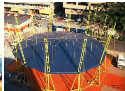
Colocación primera piedra. Edificio Wintherthur. Barcelona
