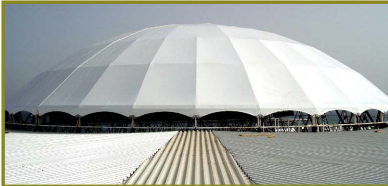
Casquete textil esférico sobre estructura monocapa para discoteca. Lanzarote
